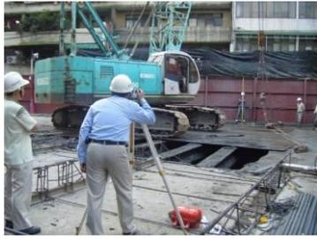
照片 4-4 鋼筋籠吊放高程檢測
