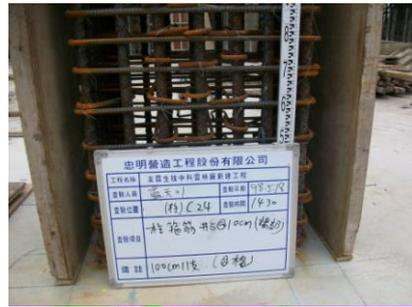
圖三九 柱筋自主檢查
