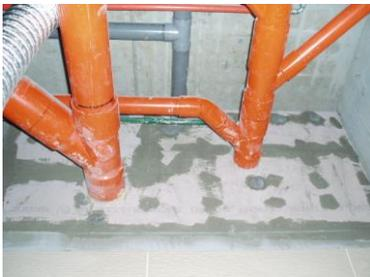
圖五 牆面孔洞填滿
