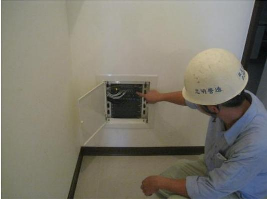
照片二十：電信箱短路測試
