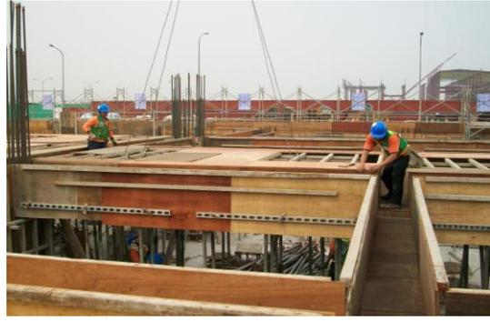
圖二九 版模固定(樑側模已完成)
