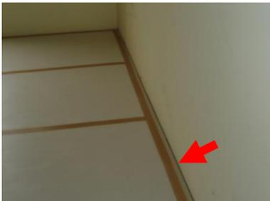
圖十一 拋光磚地坪約 5mm 伸縮縫隙
