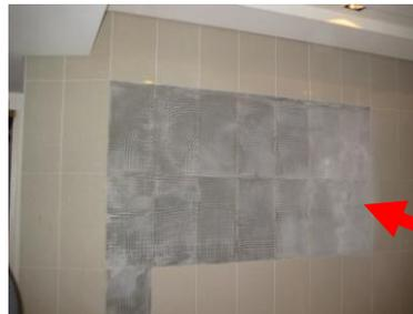
圖七 改善前牆面拋光磚整面脫落
