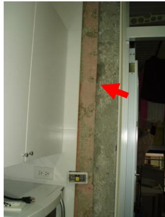
圖十三 R.C 牆與輕隔間交接產生裂縫能以包覆處理
