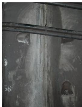
照片 5-3 隧道環片止漏完成
