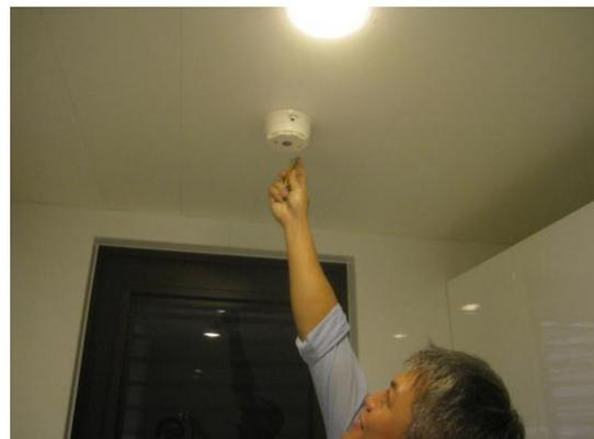
照片十九:瓦斯偵測器測試
