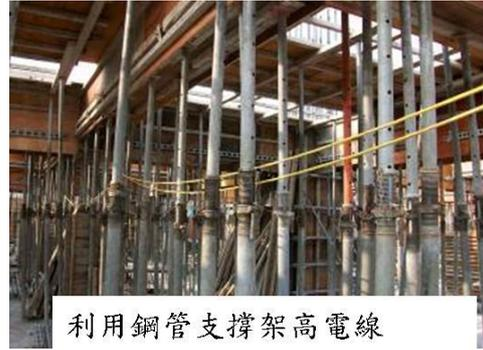
利用鋼管支撐架高電線
