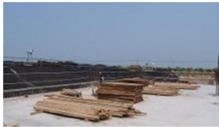
模板拆除後置放施工動線外,並堆置整齊
