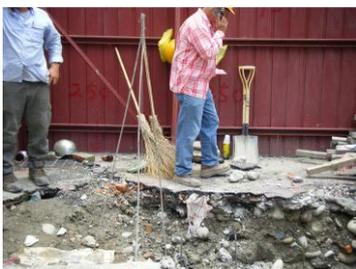
照片 3-4 壁外攪拌樁垂直度檢測
