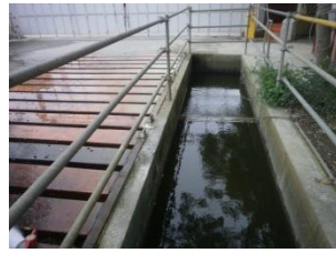
洗車台及沉澱池設置及車輛人工清洗
