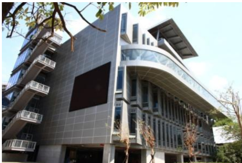
Fig：建物西側的設計，是透過開窗角度避免陽光直接照射，同時又可以獲得間接的光線照明。
