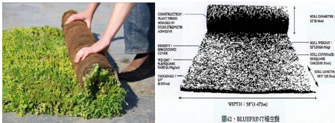
Fig：以預先在溫室培養之（地被多肉植物、馬齒莧科多肉植物）植栽毯，鋪設於屋頂上。減少施工時間，並且便利施作。
