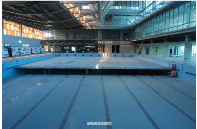
Fig：游泳池體之浮橋系統
