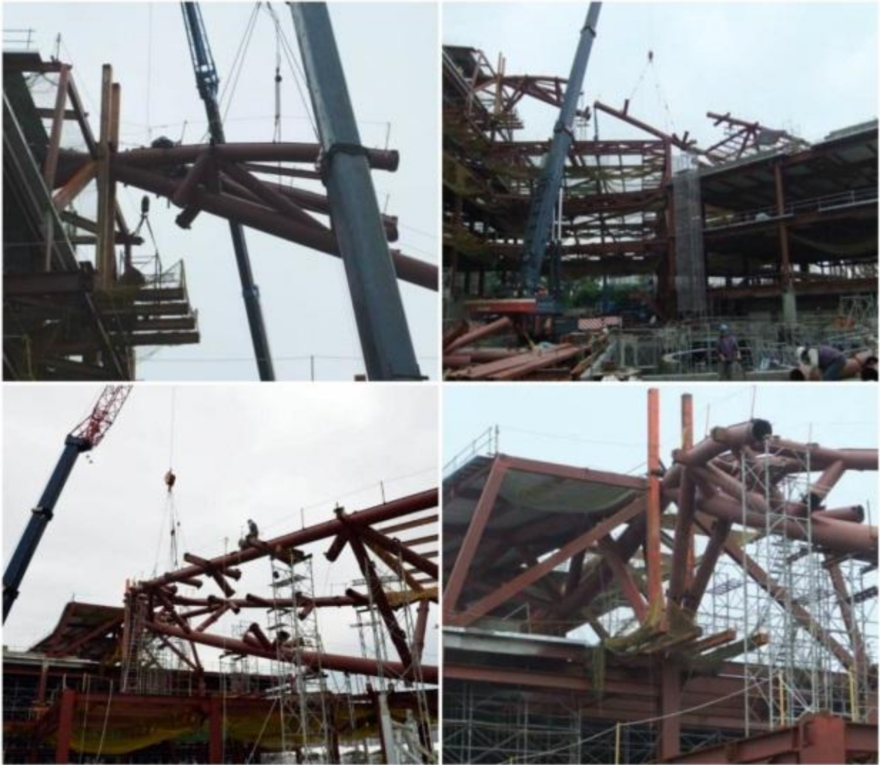
Fig：圓管構斜對接焊接困難、雙斜反曲點施工及定位困難
