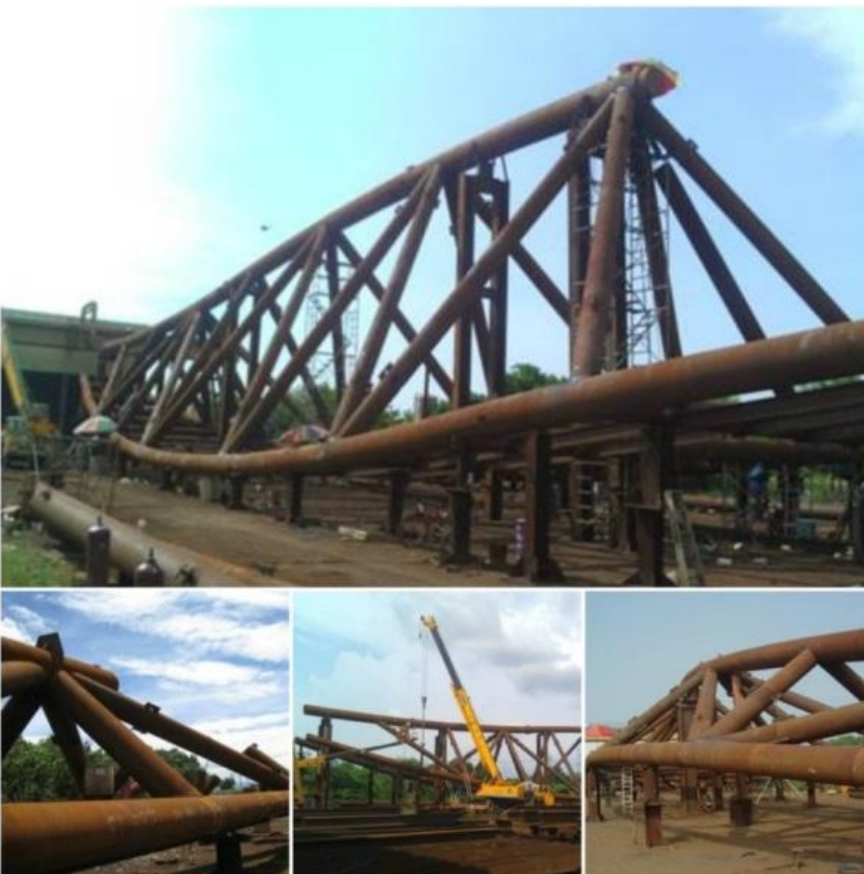
← Fig: 99M 大跨距桁架結構系統
