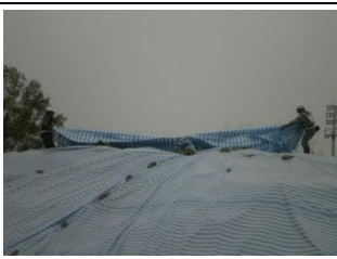
暫置土方加蓋帆布、設置洗鞋池及衛生設備
