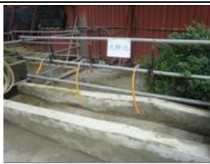
暫置土方加蓋帆布、設置洗鞋池及衛生設備
