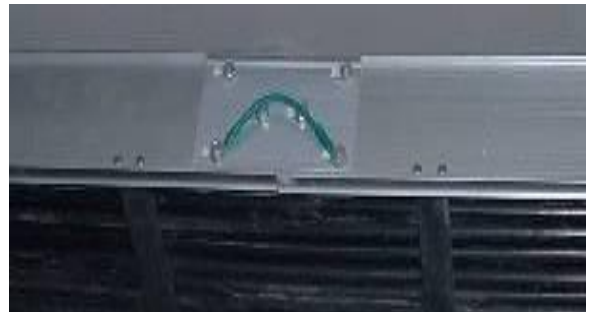
圖 32 電纜架間應以接地線銜接
