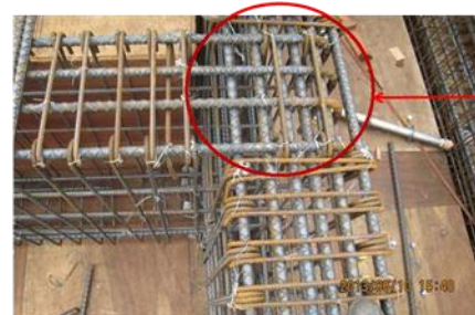
圖 梁箍筋中斷
