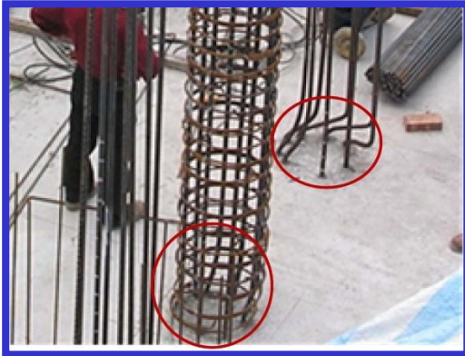
圖 柱主筋位置放樣錯誤以任意偏折方式處理
