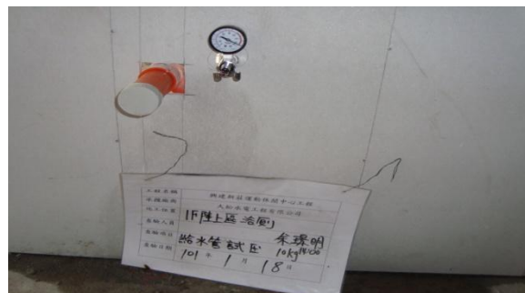
圖 12 室內裝修粉刷前壓力試驗
