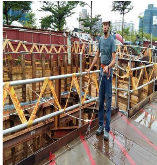
圖 如施工構臺邊緣護欄拆除，應設置安全母索並使勞工使用安全帶等防墜措施
