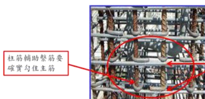
圖 柱箍筋施工品質不良問題
