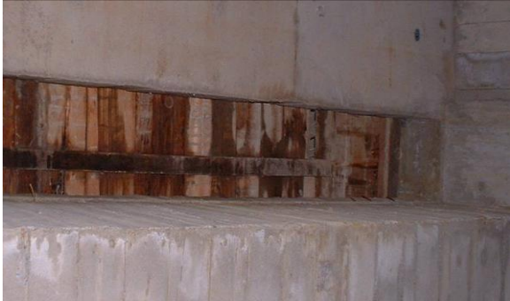
圖 43 管道開口封閉
