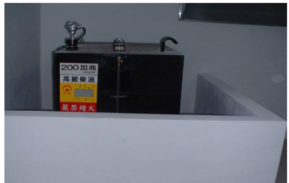
圖 38 油槽加作防油堤保護
