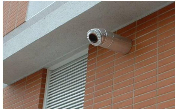
圖 37 排煙管施作隔熱包覆
