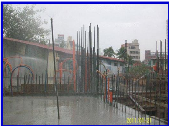
圖 18 自動灑水養護混凝土
