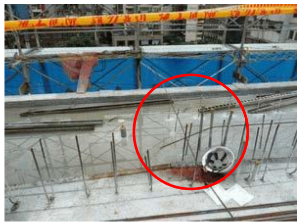
圖 現場搬運通道。工地地面濕滑，暴露之鋼筋未採取防護設施而肇災
