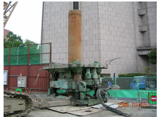
照片十一 斜交處舊連續壁鑽掘
