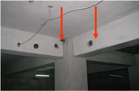
圖 穿梁孔留設位置距離柱邊未達 2 倍梁深以上
