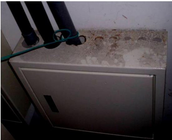
圖 18 銜接處應密合，避免有縫隙
