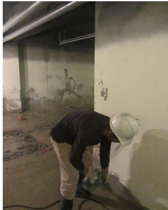
圖 使勞工進入營繕工程工作場所作業，應使其正確戴用安全帽
