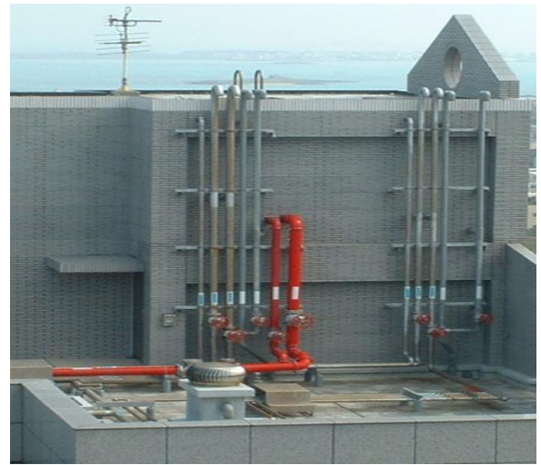
圖 32 通氣管末端加裝防蟲網
