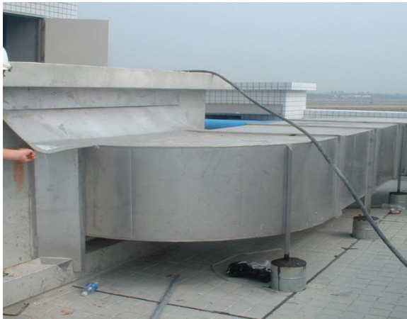
圖 17 加裝設檔雨板
