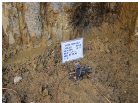
圖 5 接地熔接
