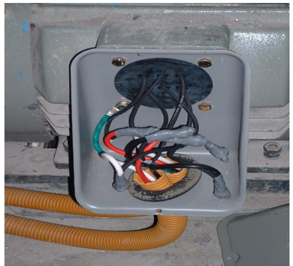
圖 16 電源接線設備接地連接
