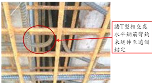
圖 牆相交處之水平鋼筋錯誤
