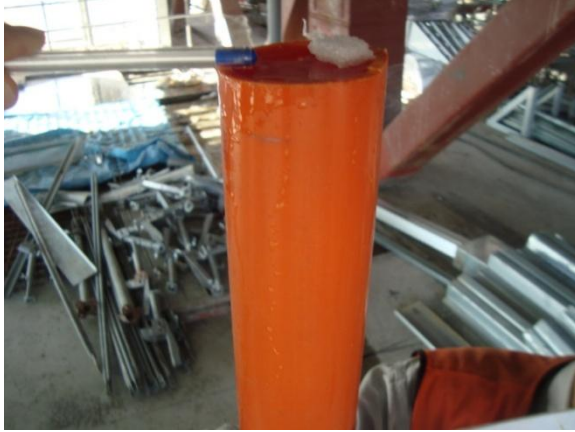
圖 48 排水管滿水試驗
