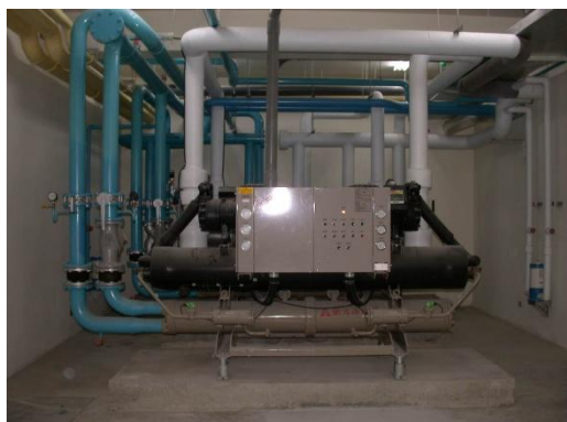
圖 3 主機基礎座須依規定施作基礎座及邊溝
