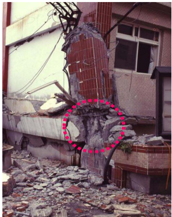
圖 柱-梁柱接頭破壞
