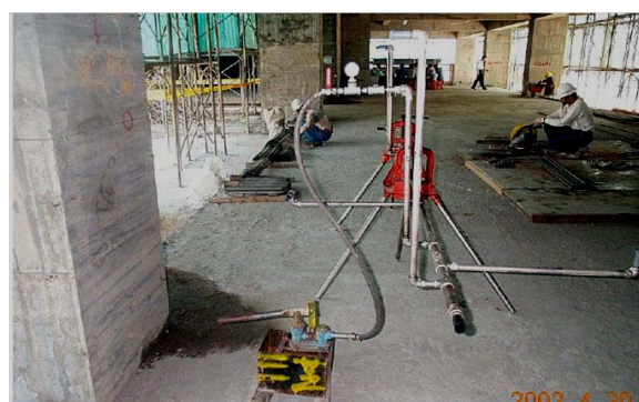
圖 6 分階段試水
