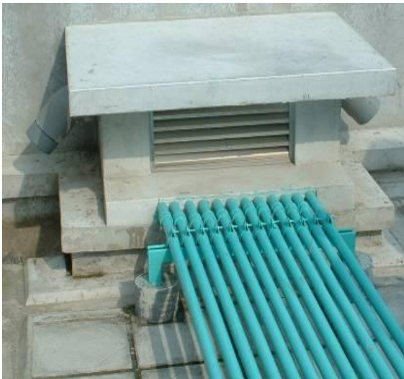
圖 31 穿越樓板時需施作防水處理
