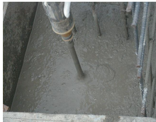
圖 23 正確方式-振動棒使用及拔初時，應儘量維持垂直方向
