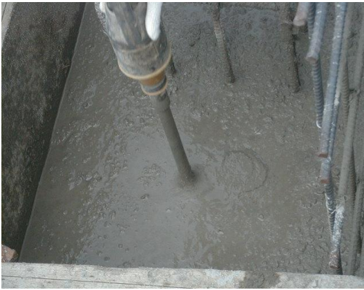
圖 9 正確方式-振動棒使用及拔初時，應儘量維持垂直方向
