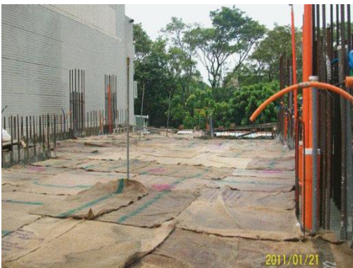
圖 20 混凝土表面以麻布袋完全覆蓋
