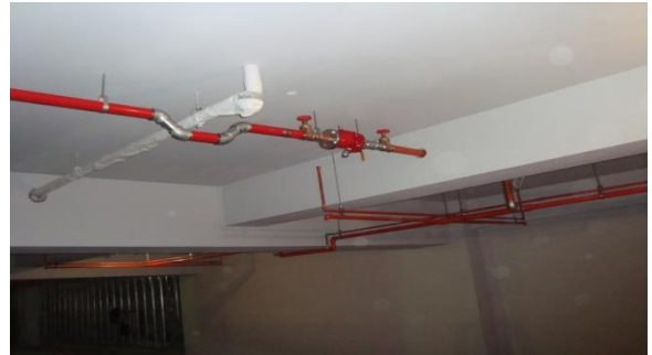
圖 35 管路衝突修正
