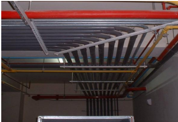
圖 30 注意固定間距與吊桿規格
