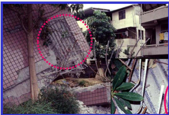
圖 柱-箍筋 90 度彎鉤破壞
