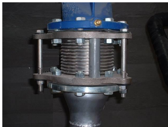
圖 4 防震軟管設限螺桿鬆緊度調整
