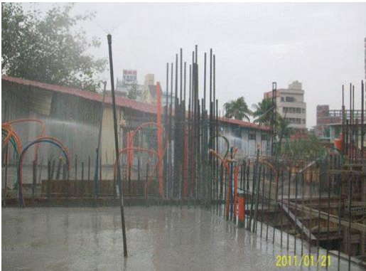
圖 19 自動灑水養護混凝土
