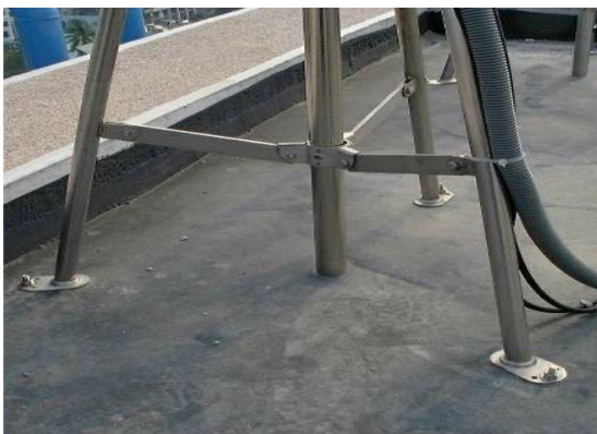
圖 8 固定架不鏽鋼螺栓施作
