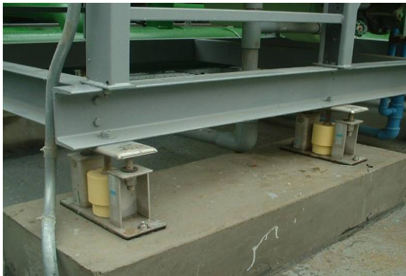
圖 7 散熱水塔防震
