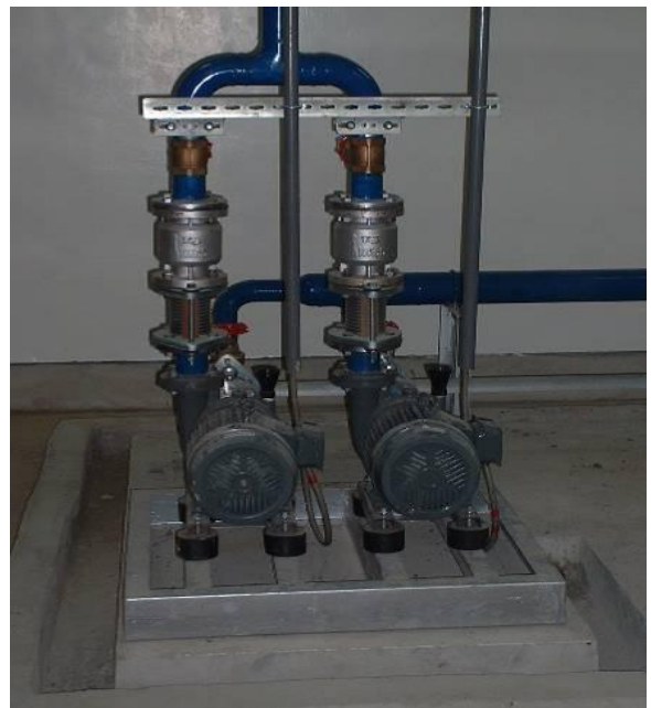
圖 18 泵底設置避震器及基礎座截水溝
