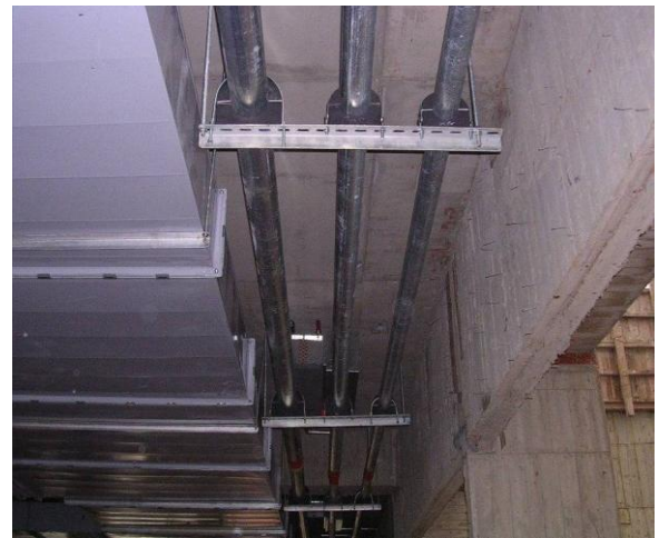
圖 20 固定於固定架上，加設隔熱管座
