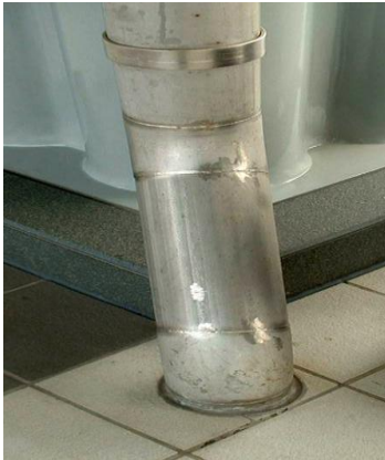
圖 14 焊接部位除渣鏽及防銹處理
