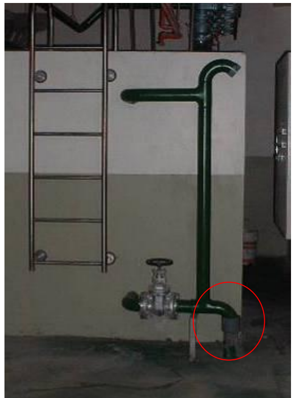
圖 28 水箱溢水及閘閥滲水可檢視
