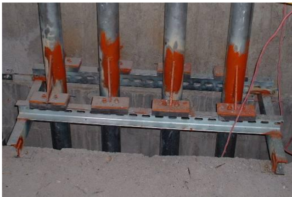
圖 18 管道固定依規定固定
