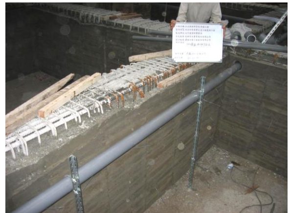
圖 32 施作固定支撐架
