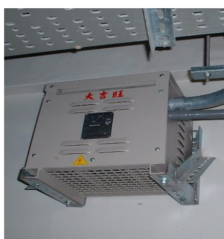
圖 43 變壓器吊掛方式安裝
