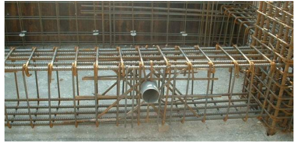
圖 45 依規定鋼筋補強
