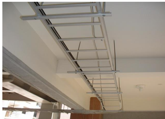
圖 16 線架依規定間距綁紮固定
