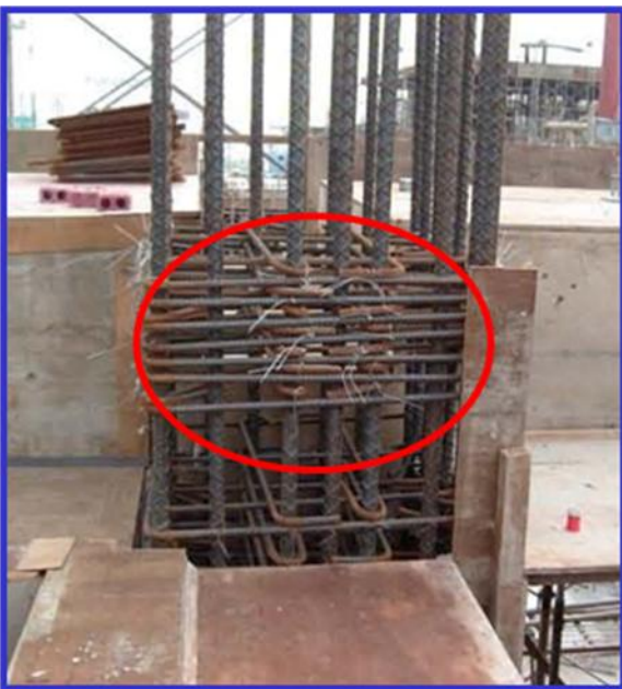
圖 梁柱接頭箍筋綁紮
