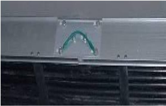
圖 17 線架銜接應有接地線銜接
