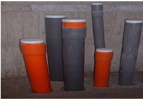
圖 44 管口封掉以免異物掉入
