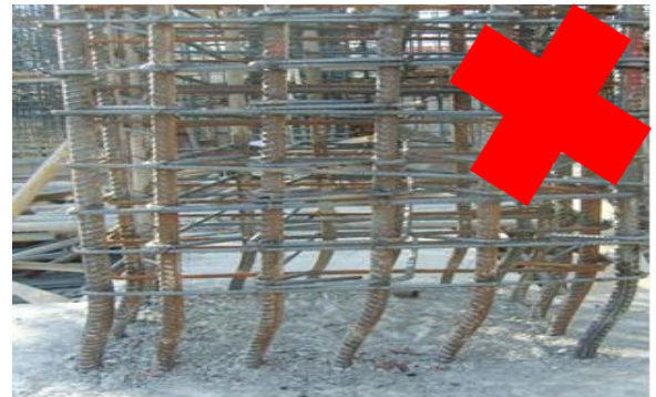
圖 柱筋放樣誤差過大
