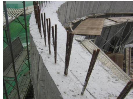
圖 未使用寬止筋造成有效深度不足
