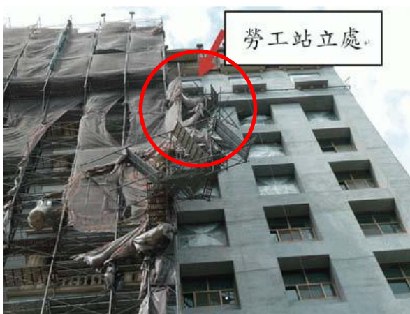
圖 勞工自損毀之施工架最上層墜落
