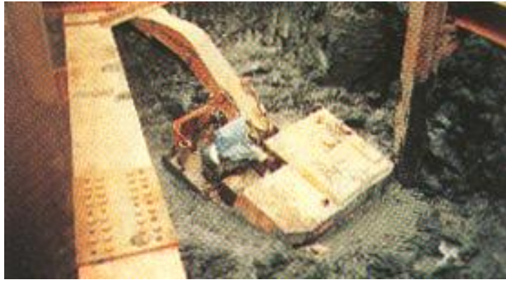
照片一 小型挖土機埋陷於軟弱黏土中
