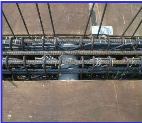
圖 穿梁孔留設位置距離柱邊未達 2 倍梁深以上
