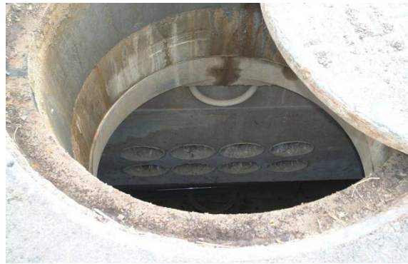
圖 33 弱電人手孔引進處管路周邊須平滑
