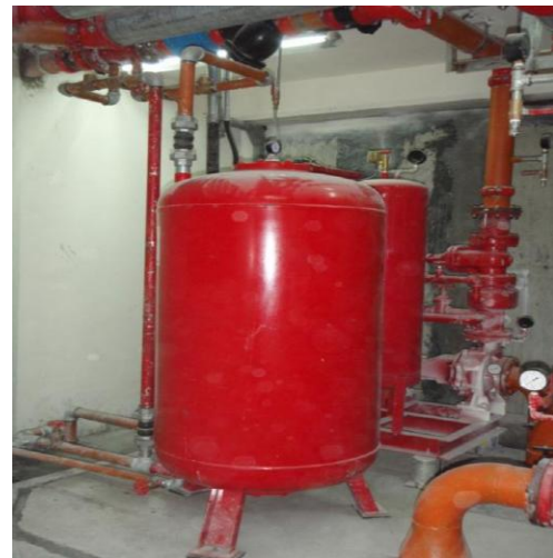
圖23泡沫原液槽
