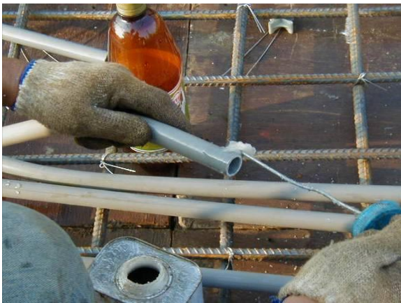
圖 13 確實使用膠合劑塗抹銜接
