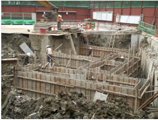
照片七 壁樁深導溝與棄土坑施作
