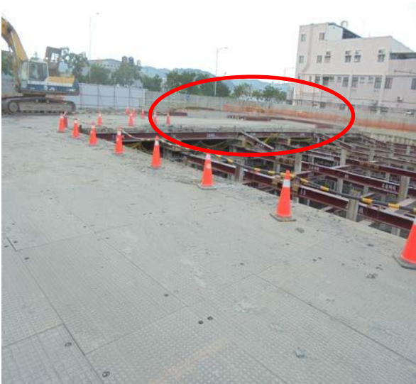
圖 圓圈處為構臺邊緣護欄已拆除
