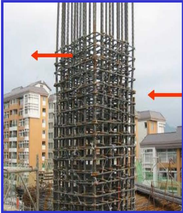
圖 柱筋偏折搭接後主筋可貼近箍筋
