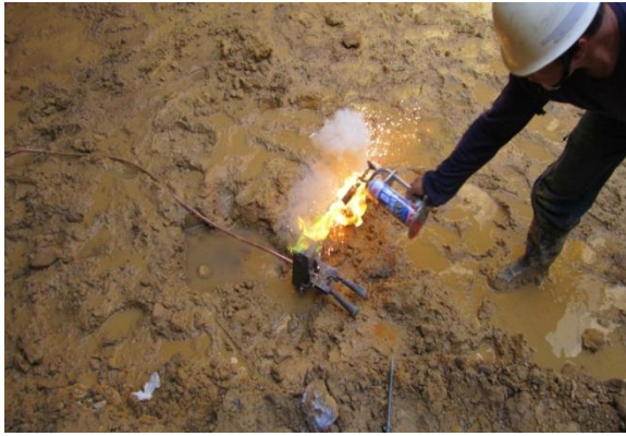
圖 6 接地線熔接
