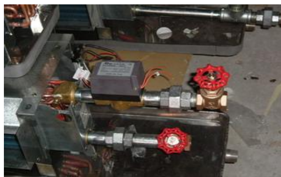
圖 5 設置由令方便事後拆裝維修
