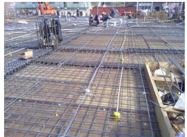
圖 12 配合鋼筋施作進度配管
