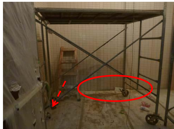
圖 災害發生現場（陳員墜落地面示意，而紅色箭頭為施工架位移方向）。
