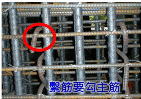
緊筋勾主筋
