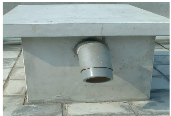
圖 41 末端施作防蟲網罩
