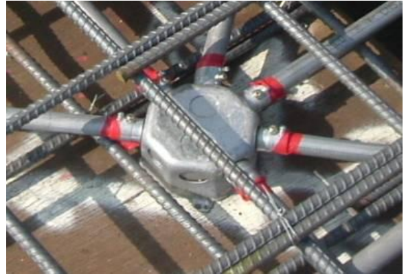
圖 15 EMT 管續接器之固定螺絲鎖斷
