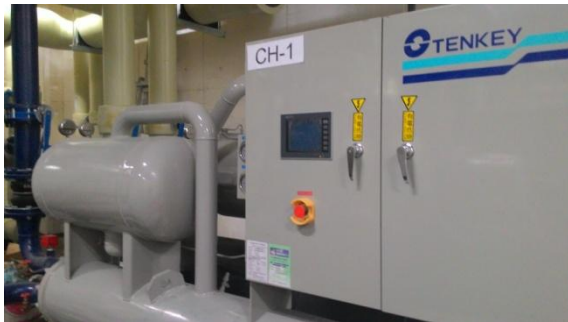
圖 24 冰水主機核對型號規格
