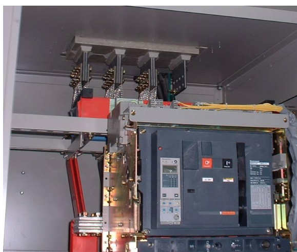
圖 41 BUS WAY 引至配電盤
