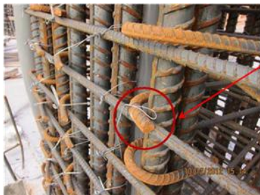
圖 柱箍筋施工品質不良問題
