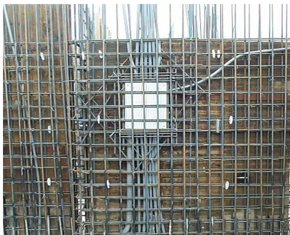
圖 20 箱體加鋼筋保護
