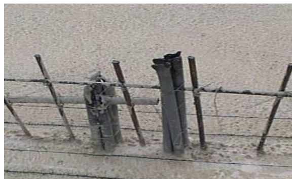
圖 26 管路封口防止異物進入堵塞
