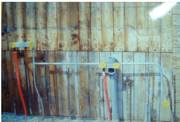
圖 8 冷(右)熱(左)水管位置
