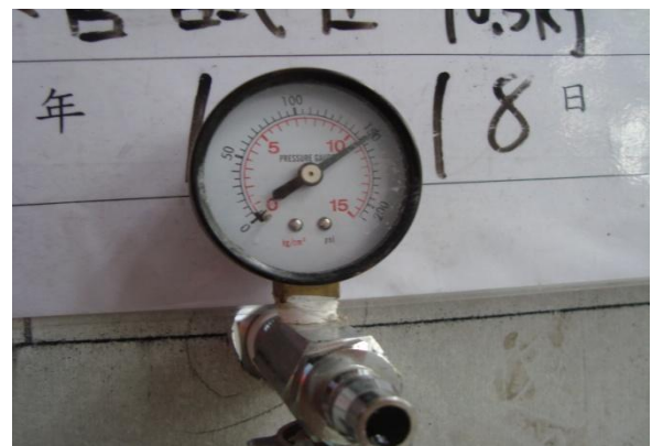
圖 22 配管完成管路試壓
