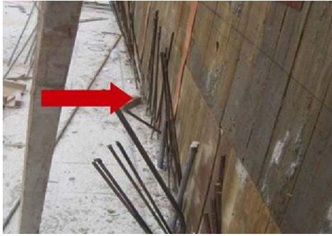
圖 預留筋與模板過近造成保護層不足
