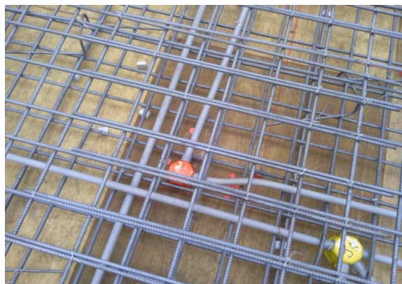
圖 14 雙層筋引入使用 S 彎管
