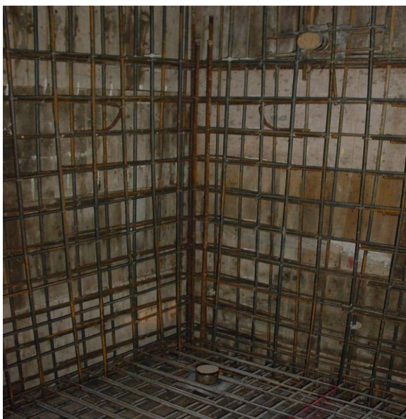
圖 26 蓄水池施作止水套管
