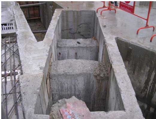
照片八 斜交處RT-200導溝
