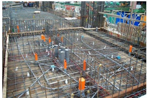
圖 46 使用過版止水套管
