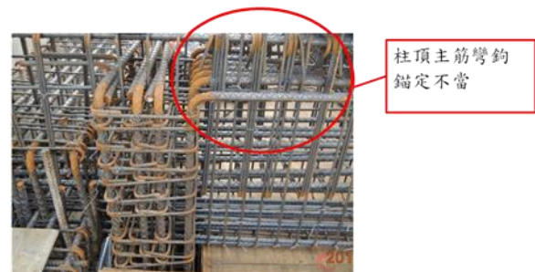
圖 柱頂主筋彎鉤施作問題
