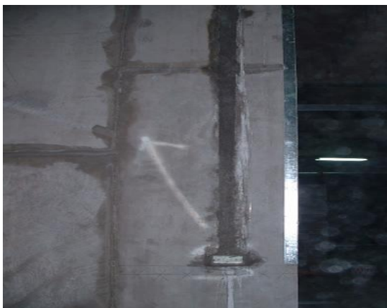
圖 25 磚牆配管固定填補
