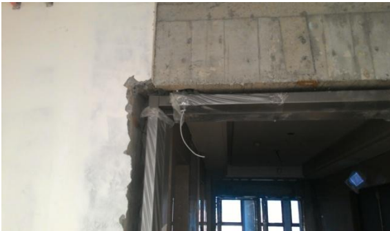
圖 31 門窗磁防於填縫前完成
