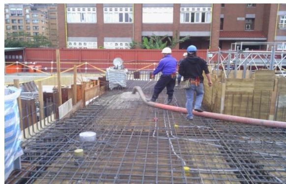
圖 23 水泥澆置時水電人員配合顧管
