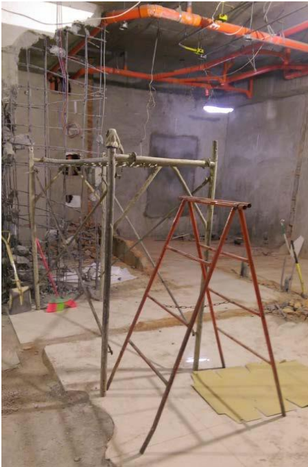
圖 災害發生現場（不得使勞工以合梯當作二工作面之上下設備使用）
