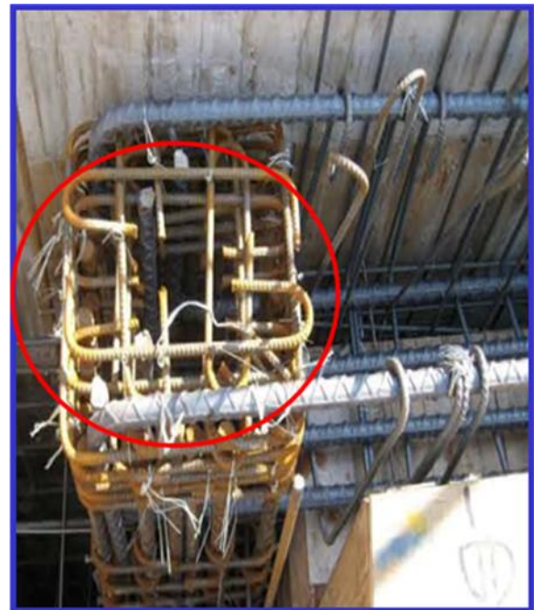
圖 柱主筋未施作彎鉤錨定
