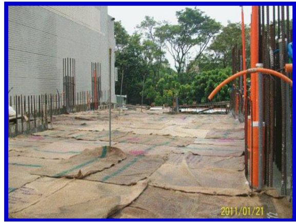
圖 19 混凝土表面以麻布袋完全覆蓋
