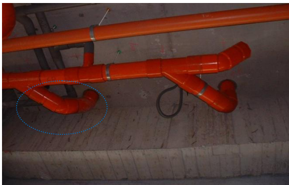
圖 38 排水管路使用 45 度接頭
