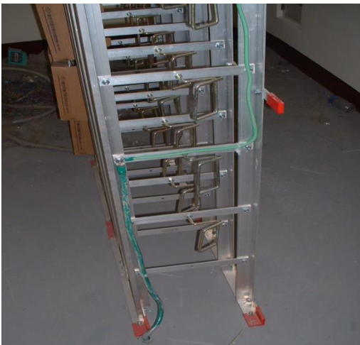
圖 24 配線架，應依規定予以接地
