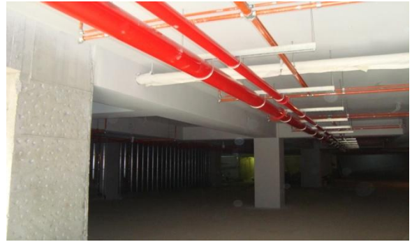
圖 34 配管依規定間距吊掛
