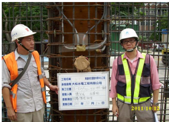
圖 19 柱牆出線口使用 S 彎管
