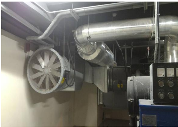
圖 12 發電機進風避開排煙管
