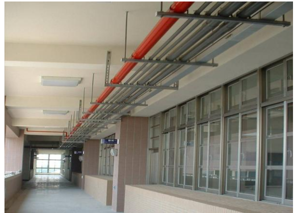
圖 17 管路依規定間距固定
