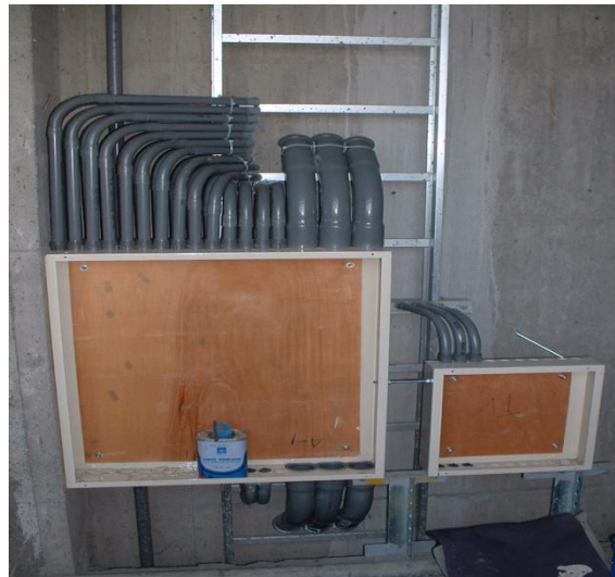
圖 15 管路銜接，不宜將配線箱直接開口引線
