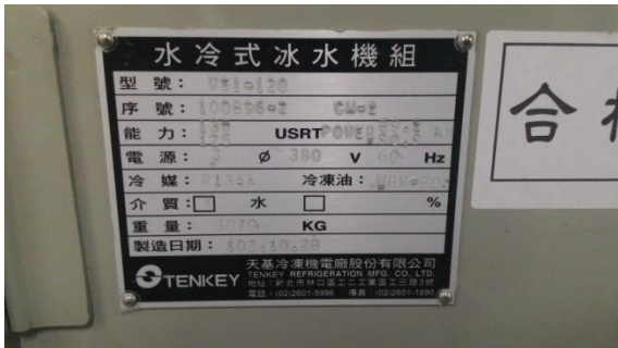
圖 25 冰水主機核對型號規格
