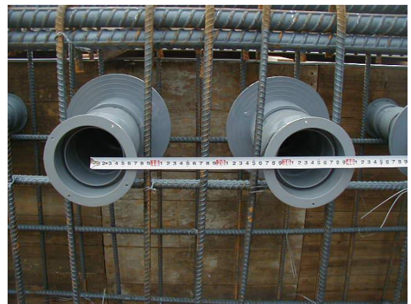
圖 33 過牆管止水板
