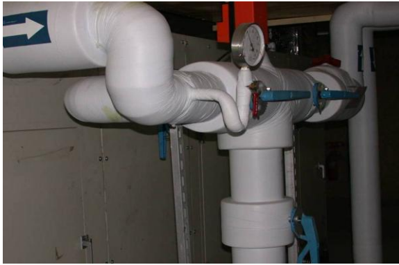
圖 23 壓力表連接彎管及溫度計銜接處，亦施作保溫
