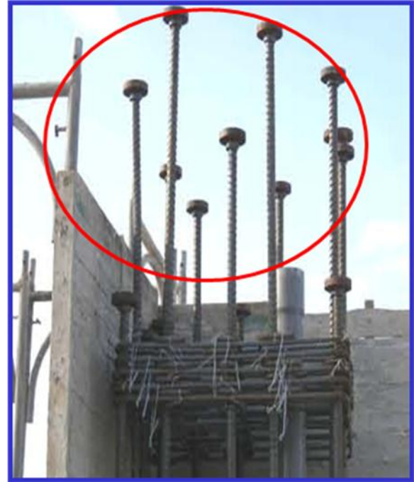
圖 柱頂 T 頭高度超過樓板面高程
