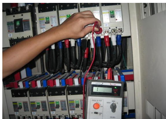
圖 44 送電前絕緣檢測
