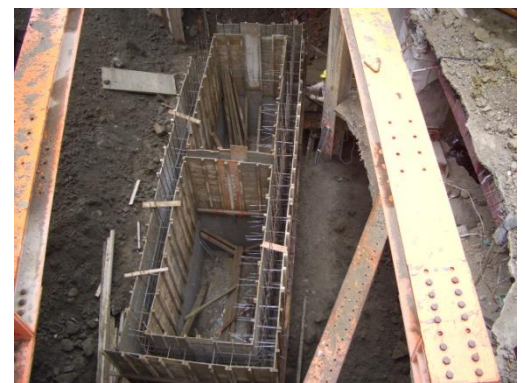
照片六 壁樁深導溝施作
