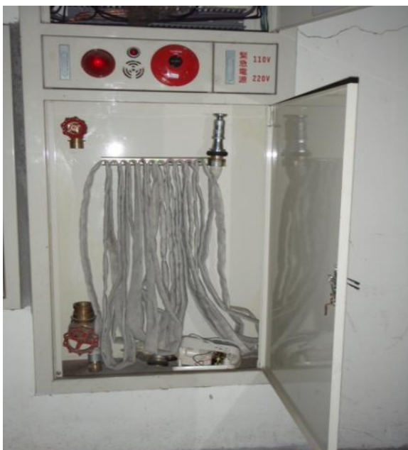
圖14室內消防栓系統架構
