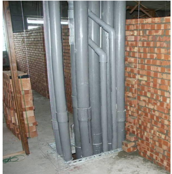
圖 40 管道間固定架間距、規劃管路排列
