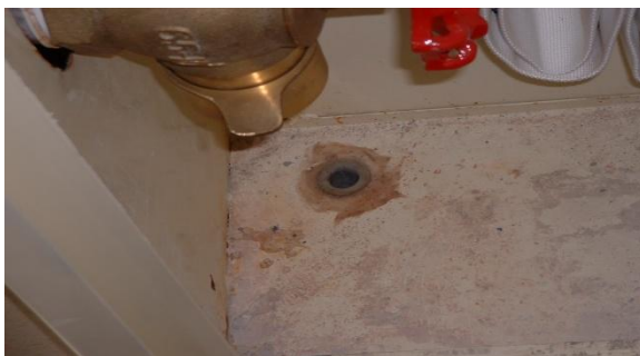
圖 33 消防栓箱內施作排水管
