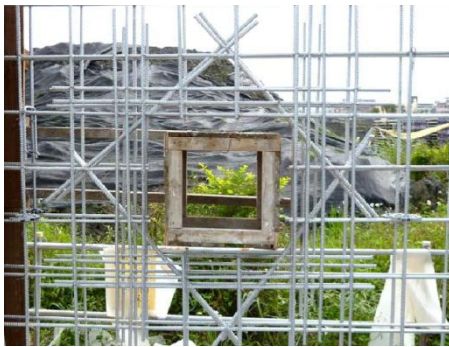
圖 牆開口補強
