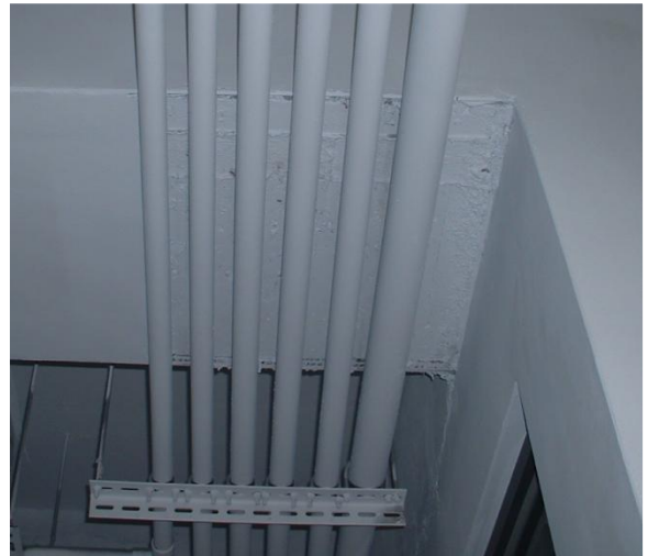
圖33管路遭油漆污損
