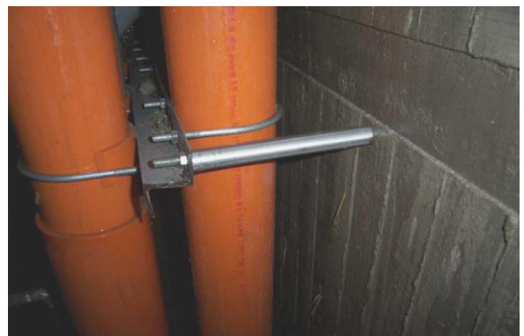
圖 42 管道間立管固定
