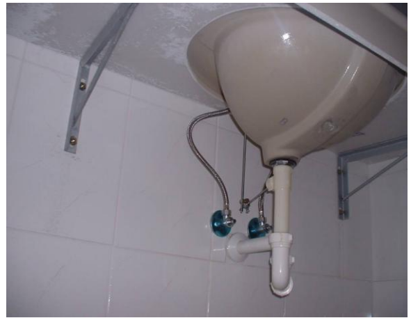
圖 22 使用不鏽鋼制式配件
