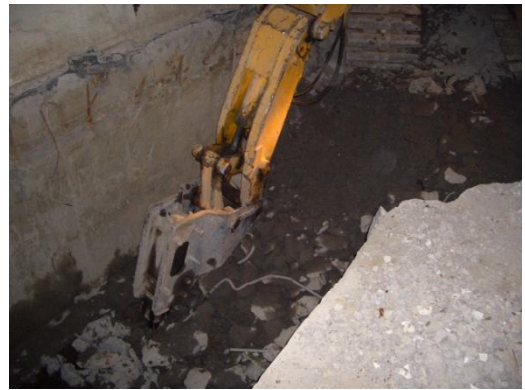
照片三 舊大底破碎打除
