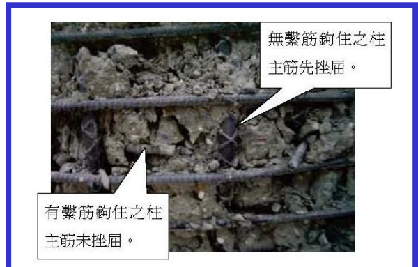
圖 柱-箍筋 90 度彎鉤破壞
