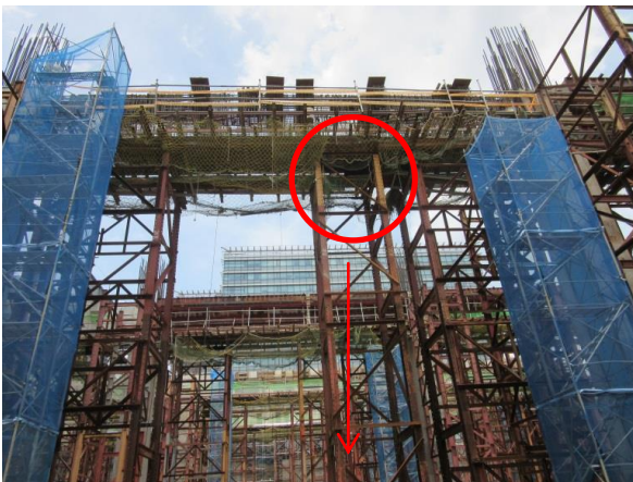
圖 罹災勞工撞破安全網後墜落至地面
