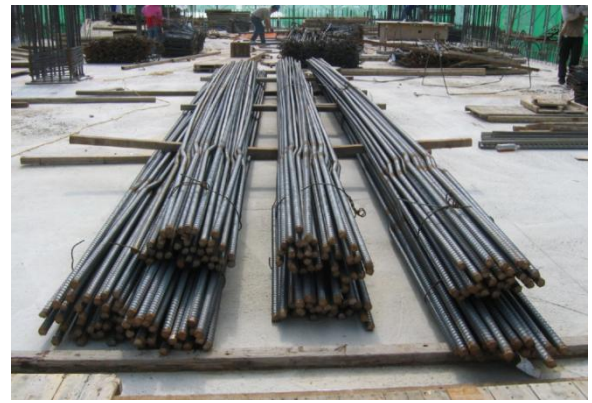
圖 須預先依規定加工彎折
