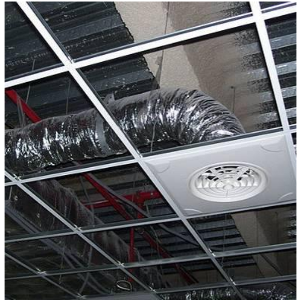
圖 9 風管銜接使用束帶緊密框連
