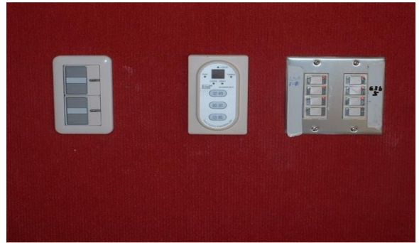
圖32各系統整合同一高程
