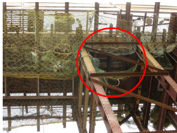
圖 罹災勞工撞破安全網後墜落至地面。
