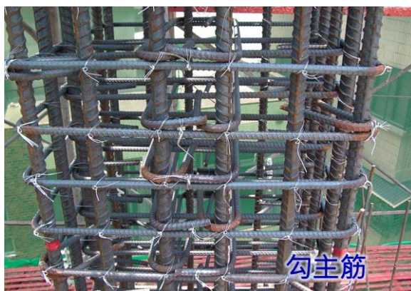
緊筋勾主筋
