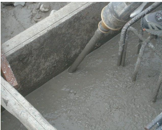
圖 11 錯誤方式-振動棒使用及拔初時傾斜
