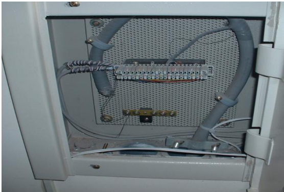
圖 7 電信箱設置接地線及接地端子
