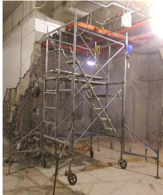
圖 災害發生現場（改善後，以移動式施工架之內爬梯取代合梯作為上下設備）。
