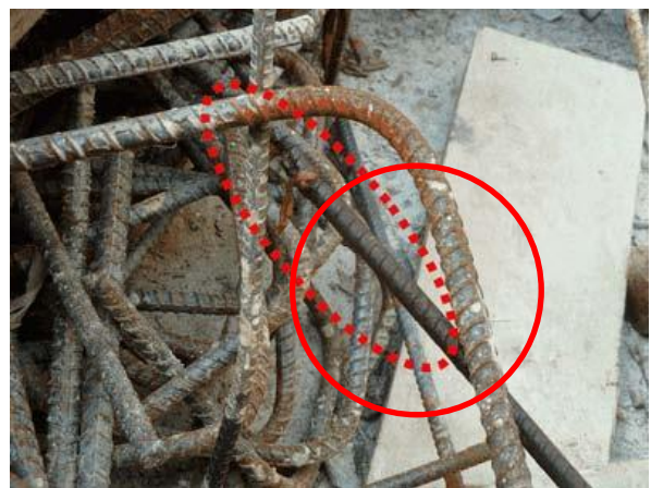
圖 工地裸露之預留筋未設防護設施，造成鋼筋自黃○○右腹部插進胸部
