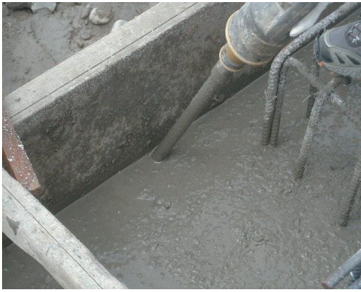
圖 24 錯誤方式-振動棒使用及拔初時傾斜
