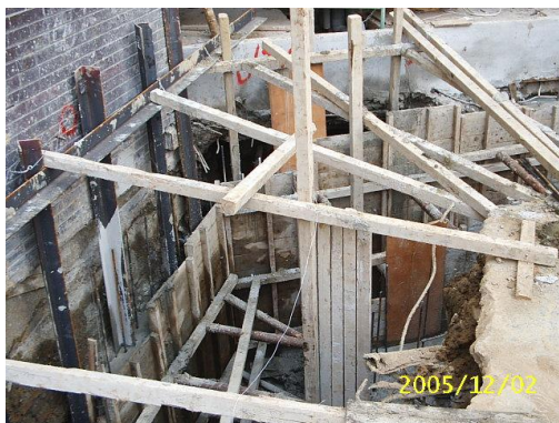
照片二 使用角鋼保護圍牆
