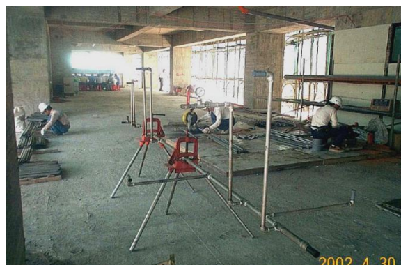
圖 5 依施工圖預先組裝
