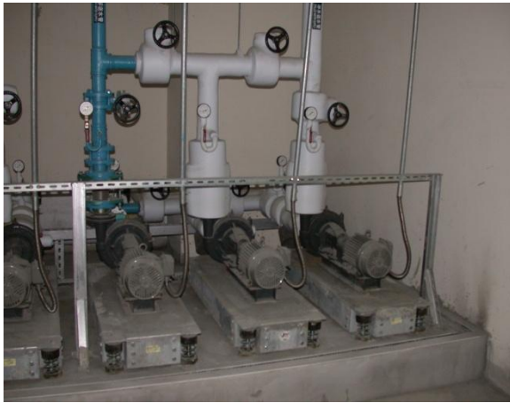
圖 6 設置邊溝及落水頭，預備泵亦應施作保溫套管。
