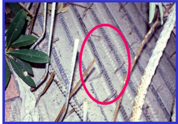
圖 柱-箍筋 90 度彎鉤破壞
