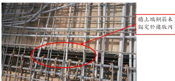
圖 牆上端鋼筋未錨定於樓板內
