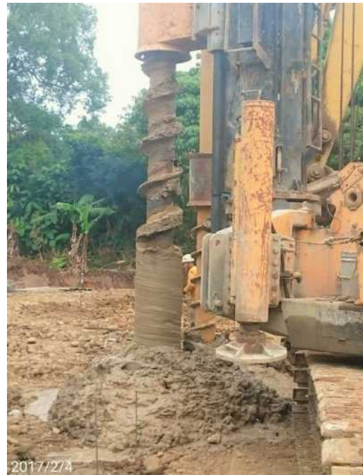
圖 17 鑽桿退出同時灌注砂漿
