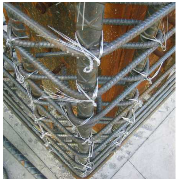
SRC柱角落斜角繫筋照片2
