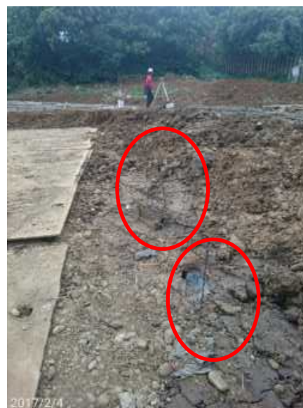
圖 13 現場以插鋼筋放樣樁位
