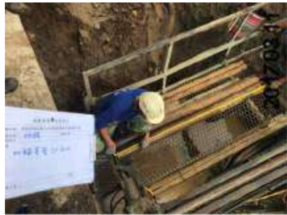
圖 39 套管長度確認(2M/支)
