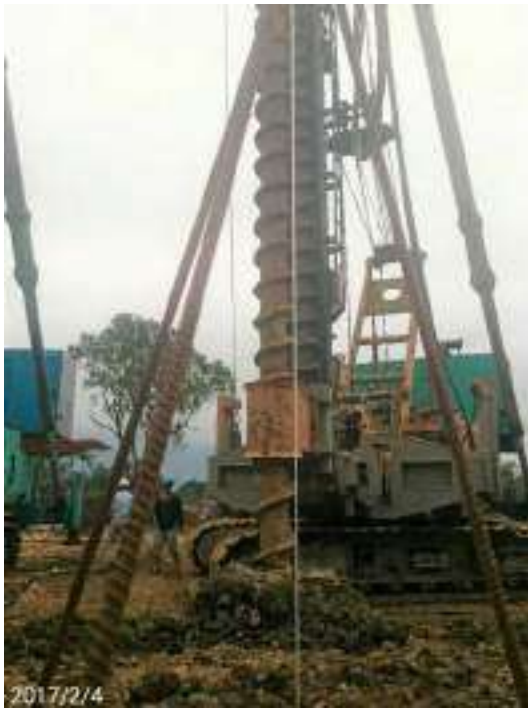
圖 15 放垂線以目視檢核垂直度
