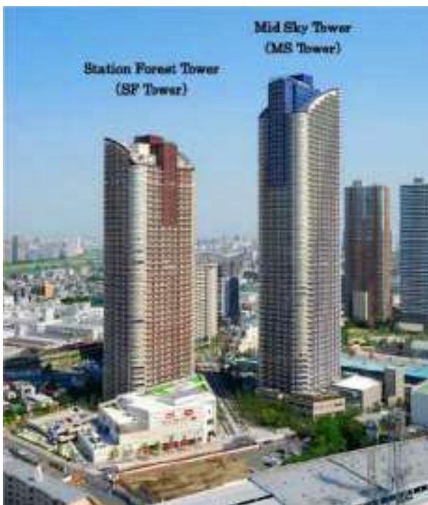
圖 26 日本神奈川縣 New RC 建築 (47F&59F · 2009 完工)
