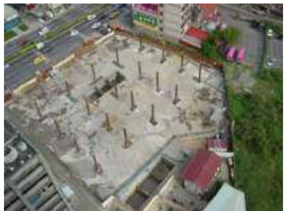
照片七 逆打鋼柱吊放及校正完成鳥瞰照片
