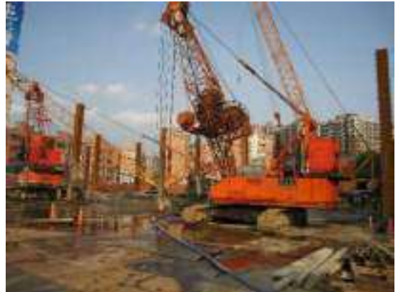
照片五 逆打鋼柱與壁樁抓掘
