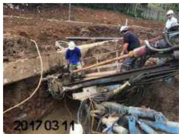
圖 41 以鑽堡開始鑽孔
