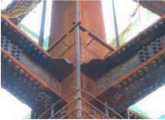
使用角鋼輔助SRC柱主筋定位
