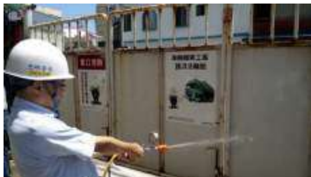
組裝完成後現場測試
