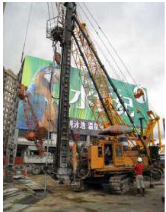
照片三 SPP地質改良施工照片
