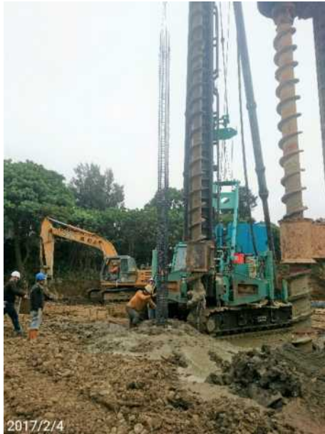
圖 19 將綁紮完成之鋼筋籠置入樁孔
