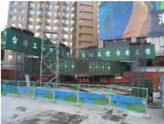
照片八 試樁組立照片
