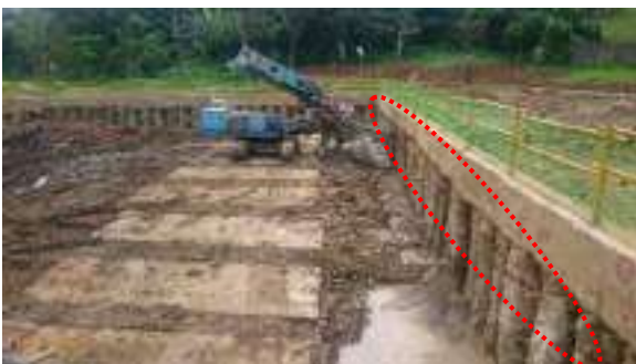
圖 38 以水線及噴漆放樣鑽孔位置
