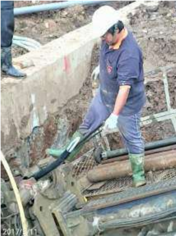
圖 47 將鋼鍵置入灌滿水泥漿之鑽孔內
