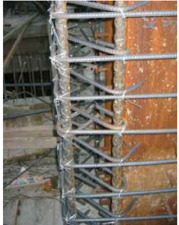
SRC柱角落斜角繫筋照片1
