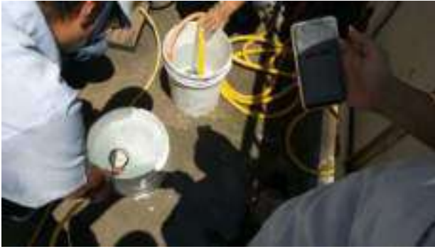
設備出水量測試
