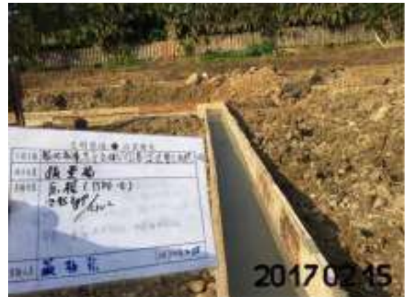
圖 23 壓梁混凝土澆置
