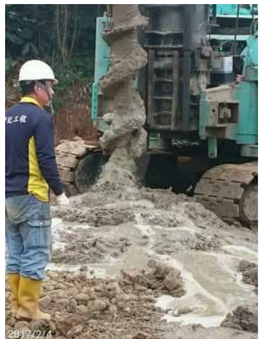
圖 18 由鑽桿端部噴出水泥砂漿
