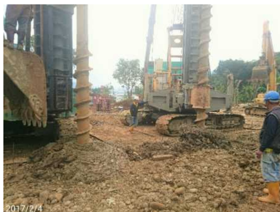
圖 14 以鑽掘機進行鑽孔作業
