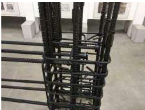
圖 31 上下層梁筋皆以 T 頭錨碇施作
