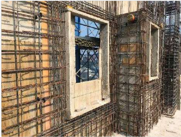
傳統牆開口及牆開口鋼筋補強結構 及開口牆施工比較
