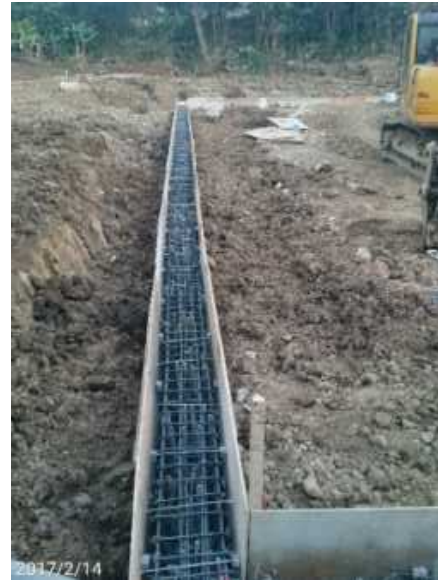
圖 22 壓梁模板組立
