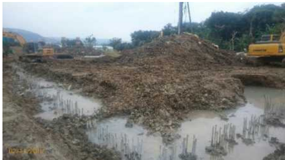
圖 20 樁頭開挖及劣質打除
