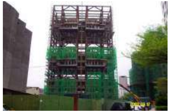
地上層三順打工法照片3
