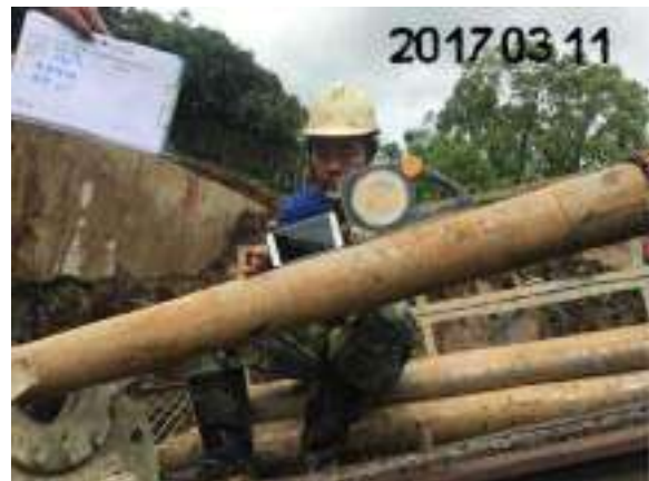
圖 40 鑽孔角度確認(20°)
