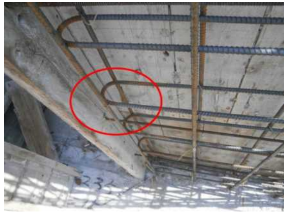
牆端部鋼筋容易忽略，尚須植入補鋼筋
