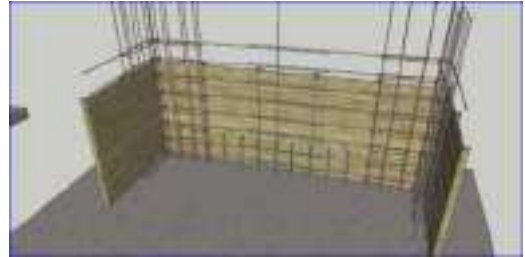
牆外側垂直鋼筋綁紮
