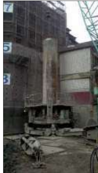
照片一 RT-200全套管鑽掘機具
