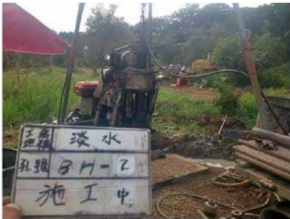
圖 5 BH-2 孔位鑽探施作
