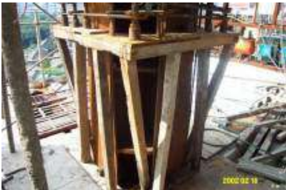
地上層三順打工法照片2
