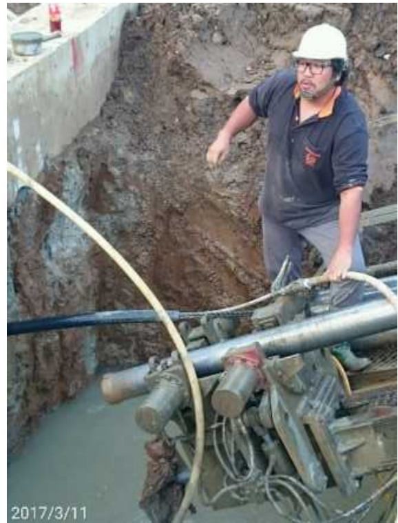
圖 49 以預留之灌漿管灌注水泥漿
