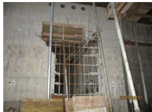
混凝土粗粒料受斜向補強筋阻隔無法填滿牆體(一)
