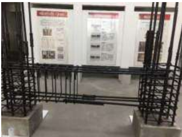
圖 30 梁筋傳統彎鉤及 T 頭錨碇之差異
