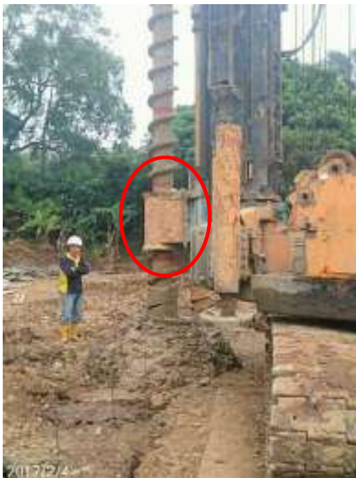
圖 16 鑽掘深度以噴漆標示
