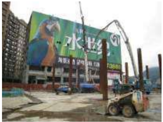
照片六 逆打鋼柱柱內灌漿
