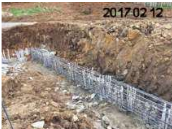
圖 21 壓梁鋼筋綁紮
