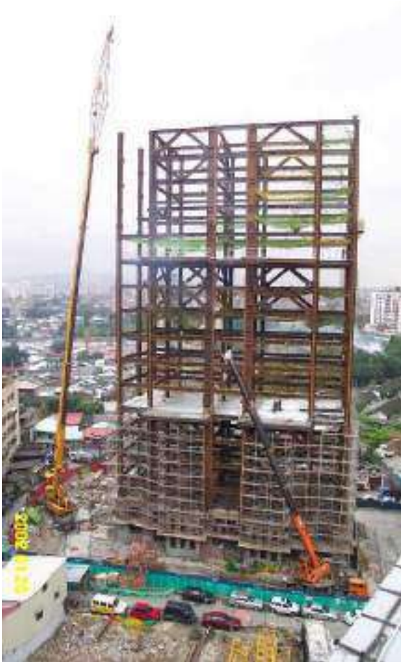
地上層三順打工法照片1
