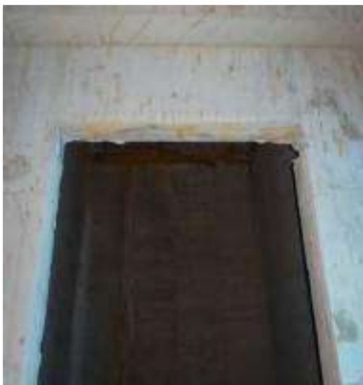
混凝土澆置面完整無蜂窩
