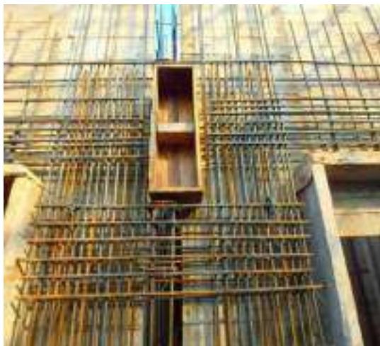
補強筋綁紮工整，鋼筋層數維持 4 層
