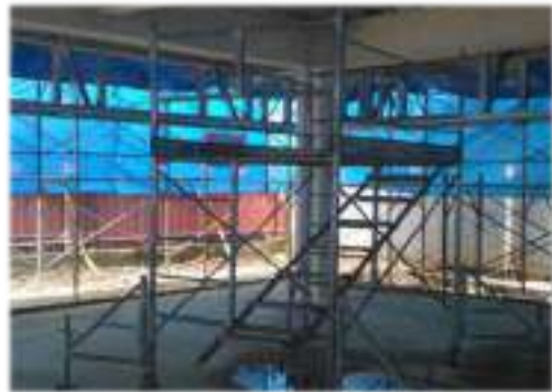
現場移動式施工架改善後
