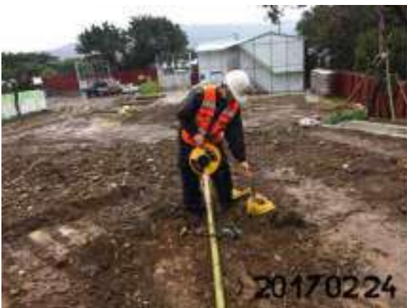
圖 59 水位觀測井量測
