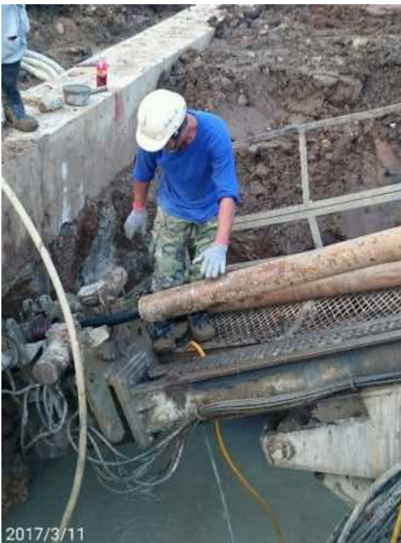
圖 48 抽出鑽堡外套管
