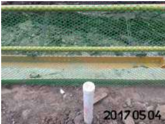
圖 63 壁體外傾度管
