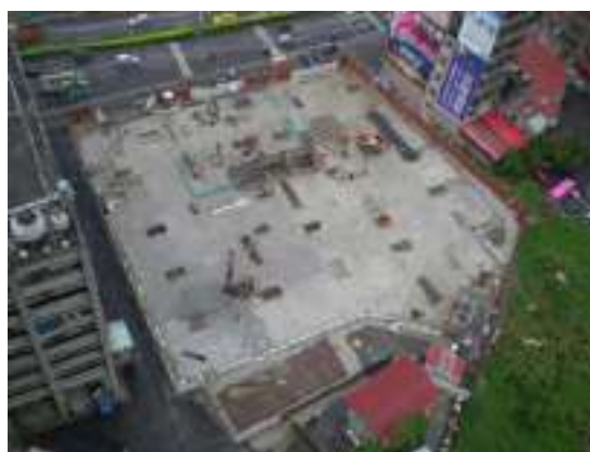
照片一 連續壁及壁樁配置鳥瞰照片
