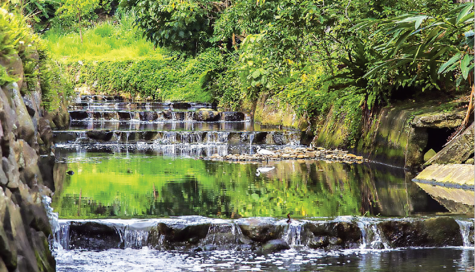
滬尾藝文休閒園區周邊河川整治
